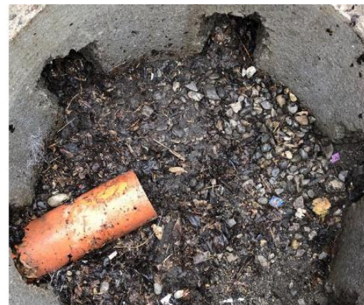
Sickerschacht verschmutzt
